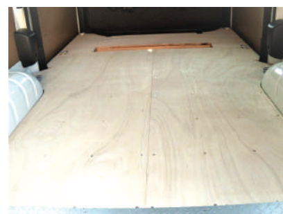
床板張り工事
